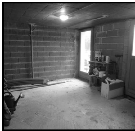
L'existant : parpaings nus, dalle béton et terre battue.
